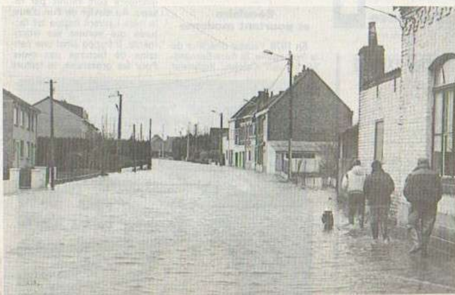
La rue de Fer reste un point critique.
